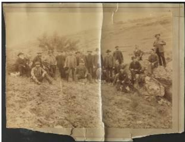
Frente antes da intervenção
