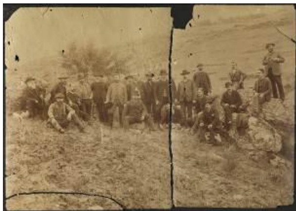
Frente após a remoção do suporte secundário
