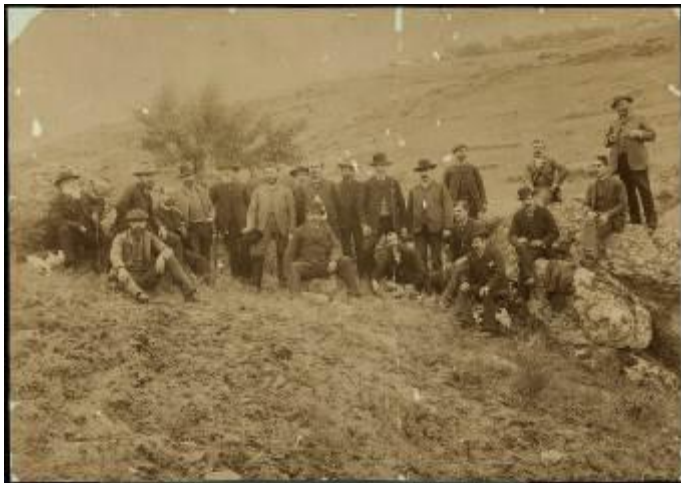
Frente após tratamento
